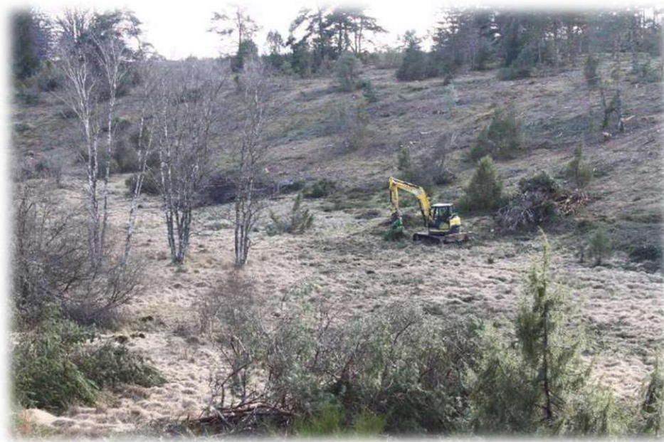
Chantier de restauration de tourbière. Haute-Vallée de la Vienne, hiver 2020-2021
