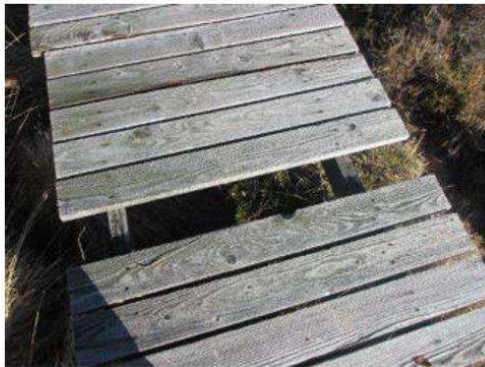
Figure 41 : Planche manquante au n° 15
