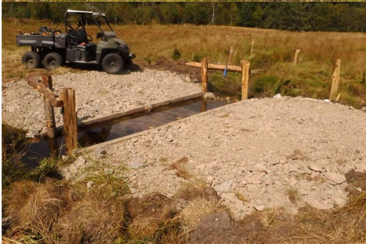
Mise en défens avec déport du fil électrique sur la parcelle voisine et descente aménagée
