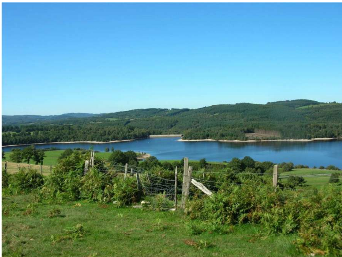
Retenue du Chammet
