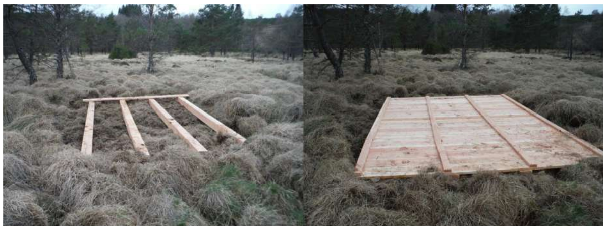
Installation d'une passerelle en bois en avril 2015 par l'équipe technique du CEN Limousin
